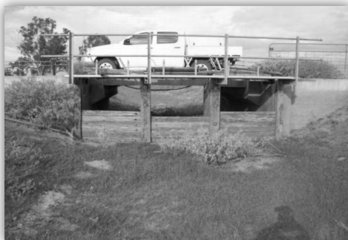
干渠手动闸板
