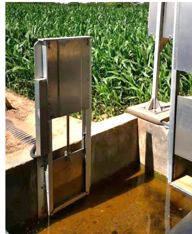
前控后测方式 几次放水后的情况，还可 以清晰的看到闸门底坎
