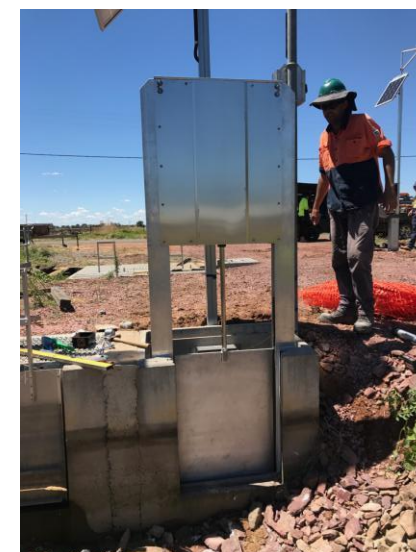
所有农场取水口改为直升式一体化闸门配电磁流量计
