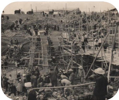
渠首闸施工现场
