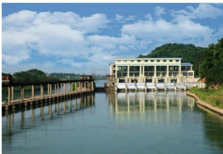
改造后的湖南省临澧县青山水轮泵站
