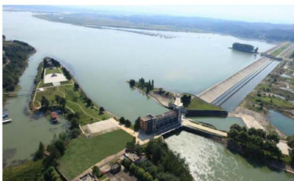
安徽淠史杭灌区横排头枢纽
