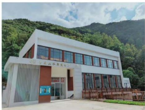
浙江省淳化县枫树岭电站(2018年 创建为一级标准化电站)
